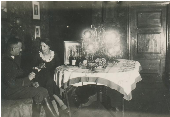
Wilhelmshof 1931 Foto: Peter Weichbrodt
