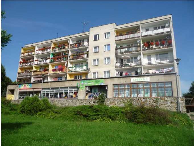
Mehrgeschossiges Wohnhaus Langestraße (im „Viertpott“)
